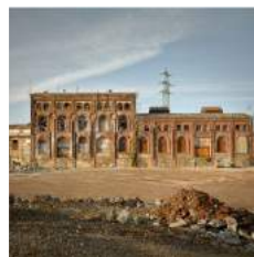
Halle des Turbines Pôle culturel
