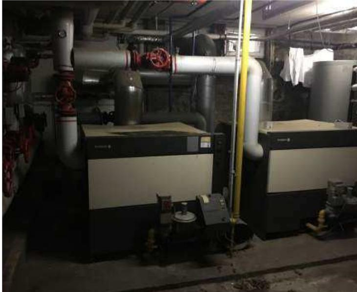
Der Technikraum befindet sich im Kellergeschoss unterhalb des Haupthauses. Heizung und Warmwasser werden mit Gas betrieben. Hierzu besteht ein Contracting-Vertrag mit den Stadtwerken Merzig GmbH. Eine Lüftungsanlage zur Zwangsentlüftung ist vorhanden.
